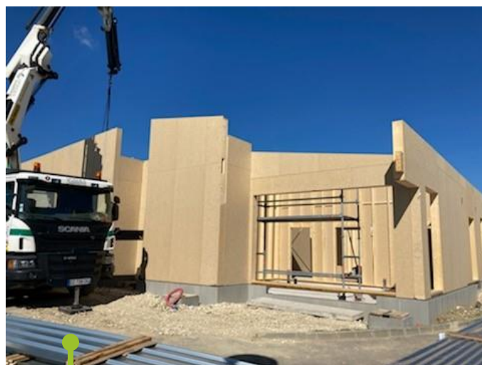
Construction du FAMPHV à Diarville
