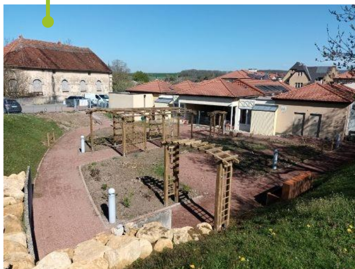
Le jardin thérapeutique de La Maison de Clervant en chantier
